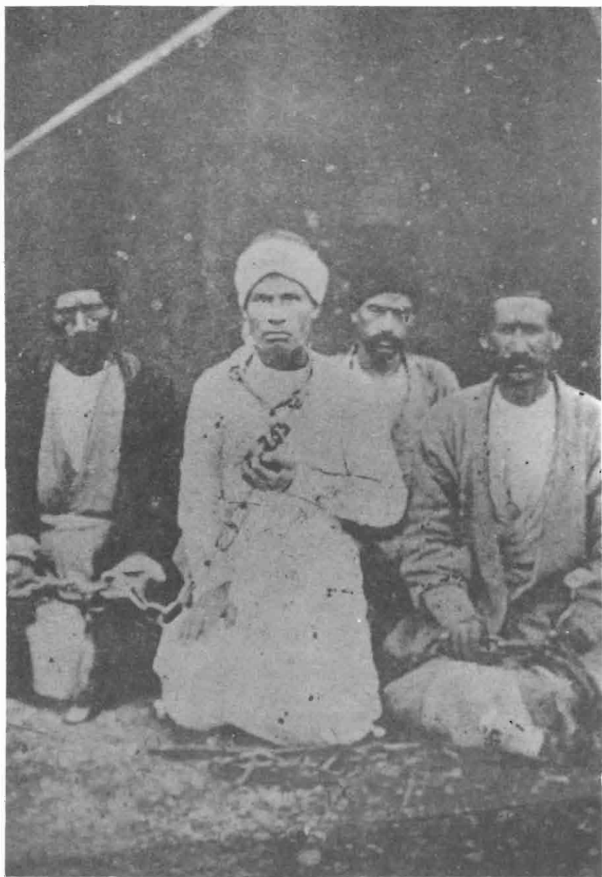
Badí cuando estaba siendo torturado. Nótese las planchas de hierro
